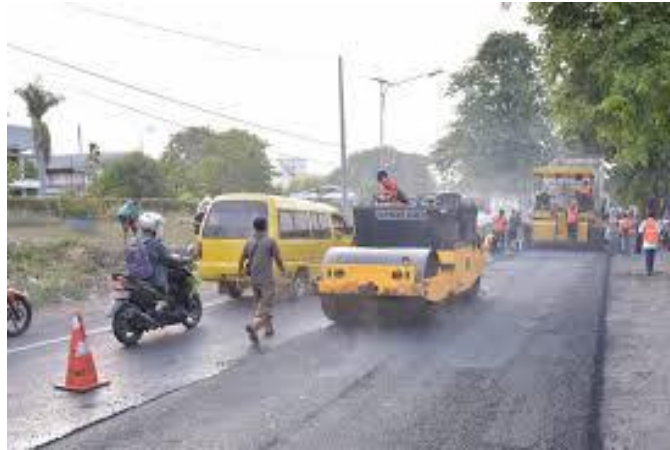
Gambar 8. Perkerasan Jalan Dengan Overlay
