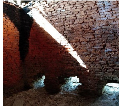
Gambar 9. Sisi dalam tungku pembakaran
