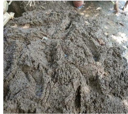
Gambar 4. Tanah liat yang sudah dicampur dengan tanah paras
