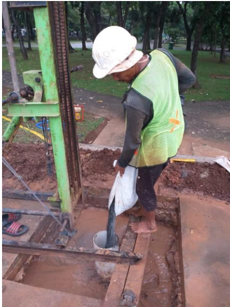
Gambar 5. Pekerjaan Pengisian Material Lubang Resapan Biopori Sumber : ( Dharsika, 2022)
