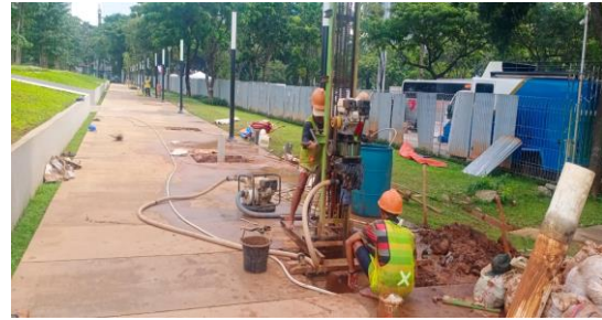
Gambar 2. Pekerjaan Pembuatan Lubang Resapan Biopori Sumber : ( Dharsika, 2022)
