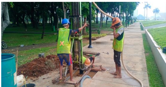
Gambar 1. Persiapan Pekerjaan Pembuatan Lubang Resapan Biopori Sumber : ( Dharsika, 2022)
