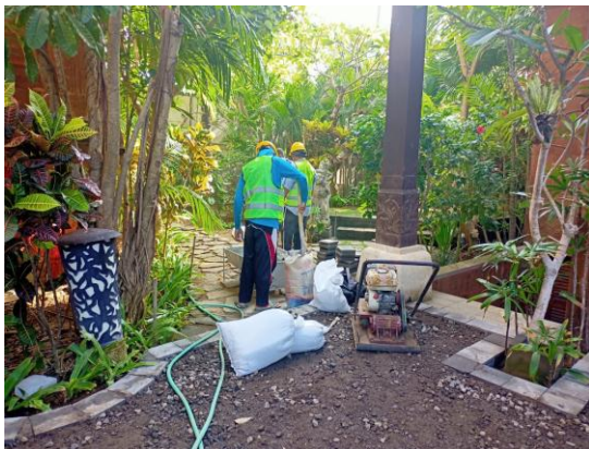
Gambar 3. Persiapan Plat Lantai Kerja Sumber : Nilawati, 2021
