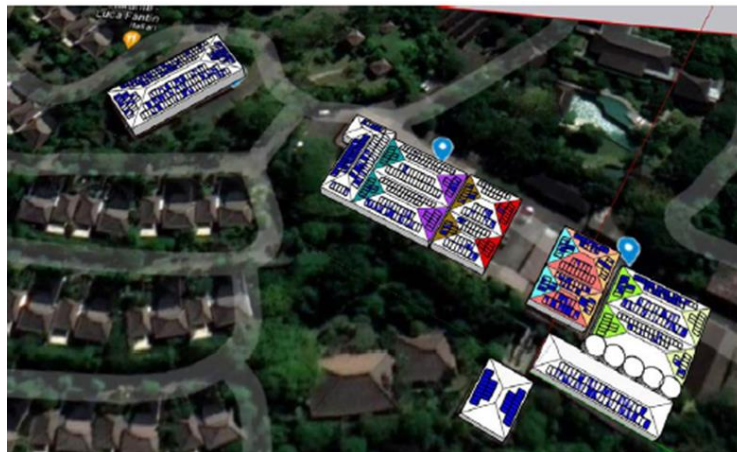
Gambar 3. Luasan area rooftop yang akan dipasang solar panel Sumber: PT Xurya Daya Indonesia
