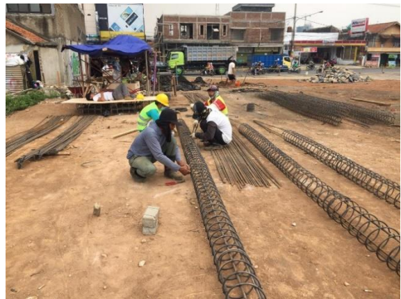
Gambar 9. Pekerjaan Pembesian Strauss Pile
