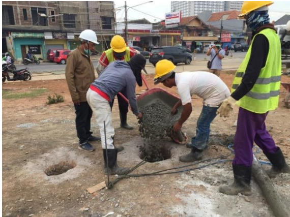
Gambar 11. Pekerjaan Pengecoran Pondasi Strauss Pile
