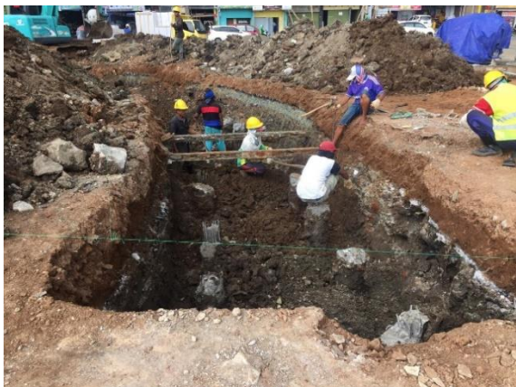
Gambar 13. Galian Pile Cap dan Tie Beam
