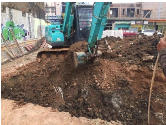
Gambar 12. Pekerjaan Galian Pile Cap dan Tie Beam
