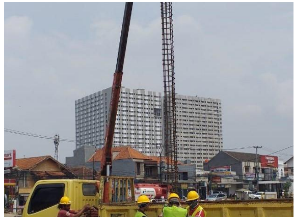
Gambar 10. Pekerjaan Pemasangan Tulangan Strauss Pile
