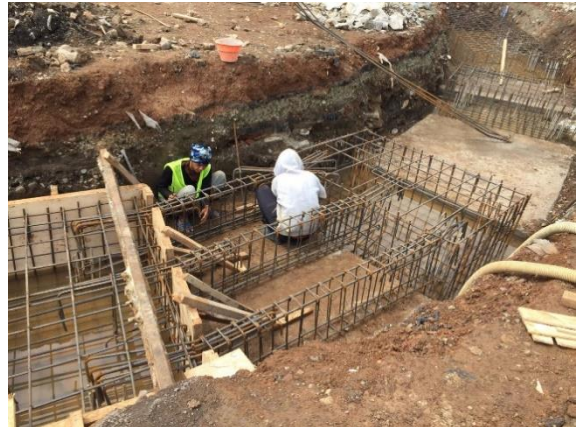
Gambar 14. Pekerjaan Pembesian Pile Cap dan Tie Beam
