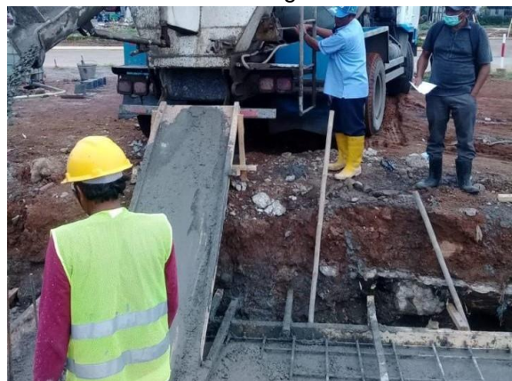
Gambar 16. Pekerjaan Pengecoran Tie Beam
