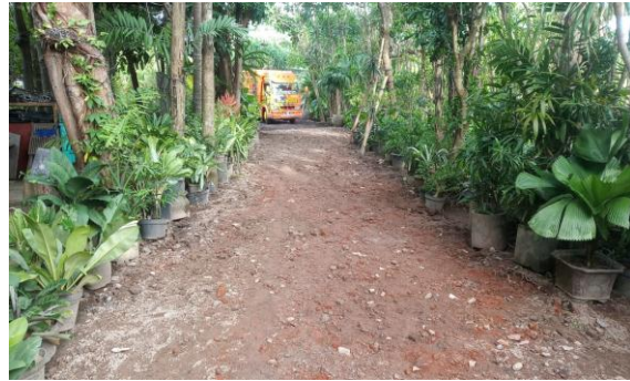
Gambar 1. Area Pekerjaan Paving
