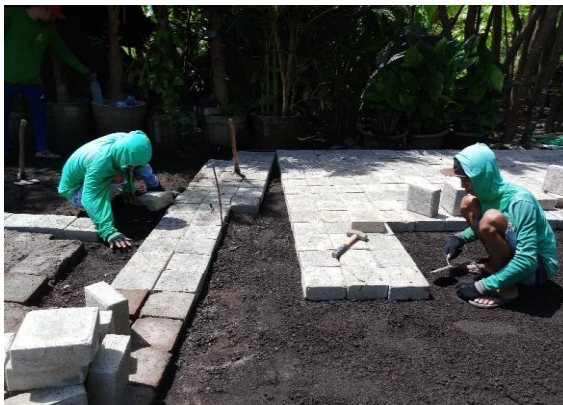
Gambar 7. Pemasangan Paving Block
