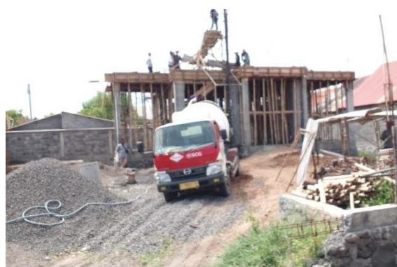
Gambar 4. Pekerjaan Kerangka Struktur Sumber : Peneliti, 2025
