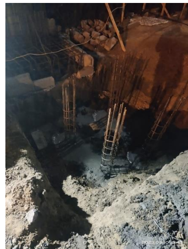
Gambar 8. Pondasi Bor Pile
