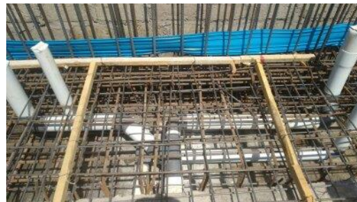
Gambar 4. Detail Pembesian Pelat Lantai
