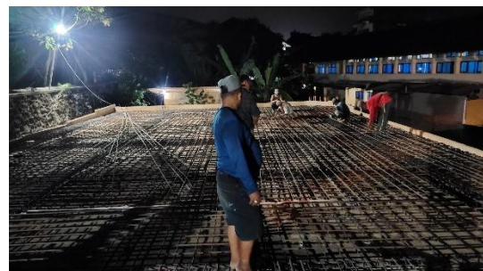
Gambar 13. Pembesian Pelat Lantai Atas
