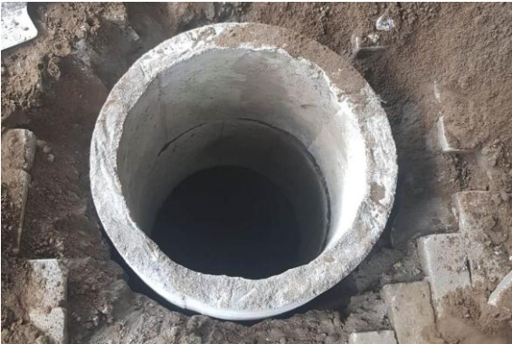
Gambar 5. Buis Beton Terpasang Sumber : (Nilawati, 2020)
