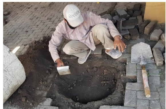
Gambar 3. Pekerjaan Galian Sumber : Nilawati, 2020)
