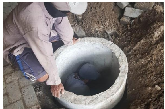
Gambar 4. Pemasangan Buis Beton Sumber : (Nilawati, 2020)
